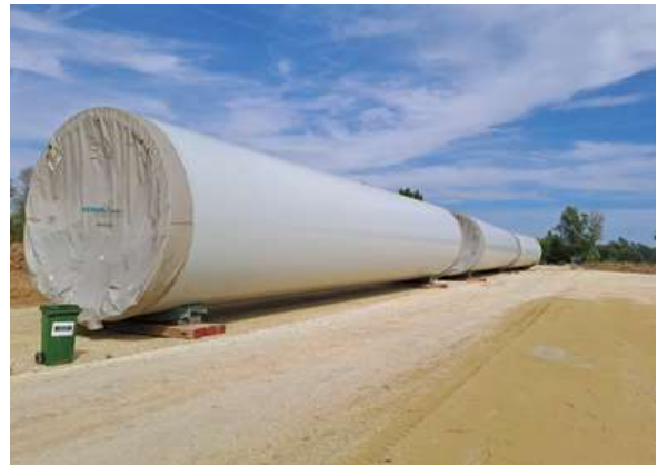
Слика бр. 20: Делови стуба ветро генератора -
