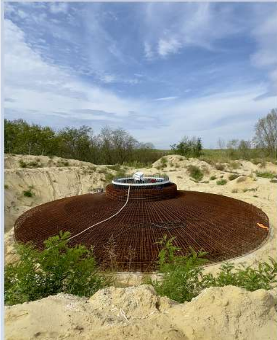
Слика бр. 19: Темељ стуба ветрогенератора -
